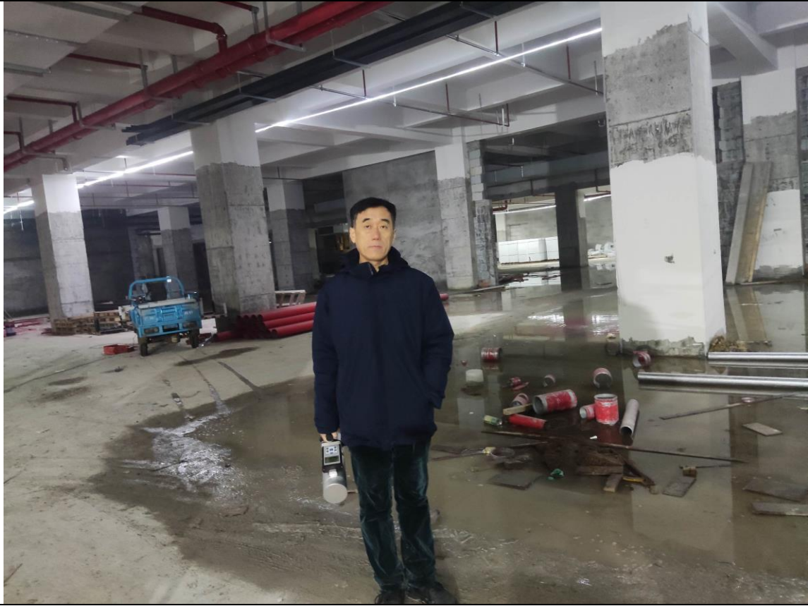
工程师现场照片 图 8-1 项目现场照片
