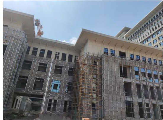
项目所在医技楼
