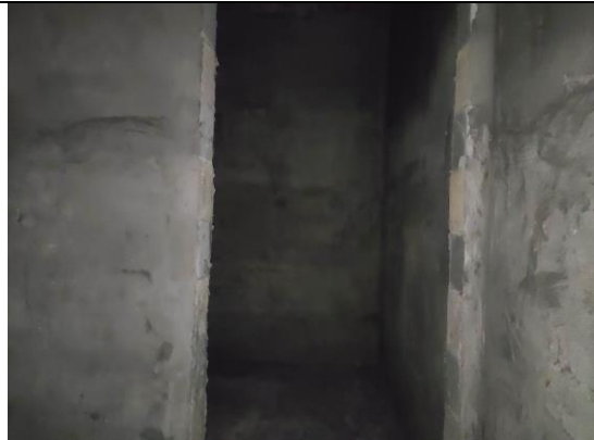
拟建直线加速器北侧冷却机房
