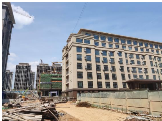
项目西侧科医生临床培训基地楼
