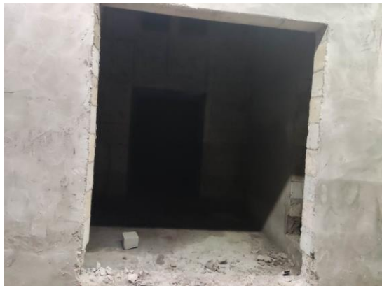
拟建后装机北侧准备大厅
