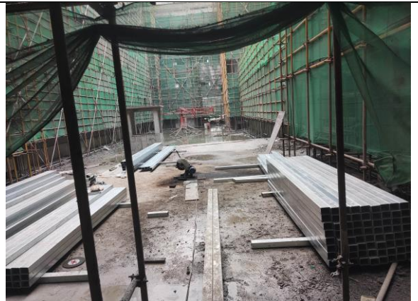
直线加速器机房正上方
