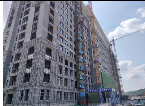
项目北侧住院楼
