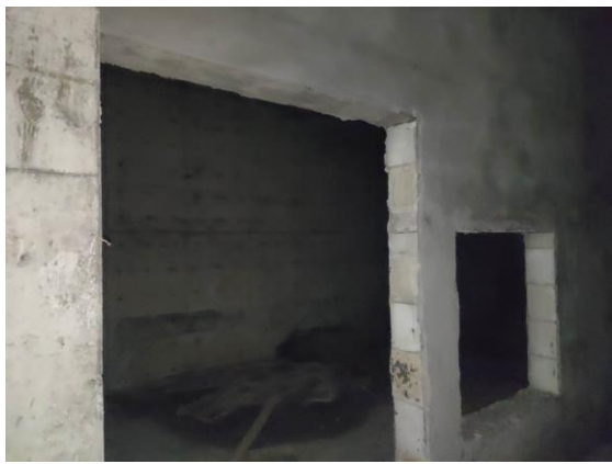
拟建直线加速器西侧进风机房
