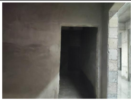
拟建直线加速器北侧控制室
