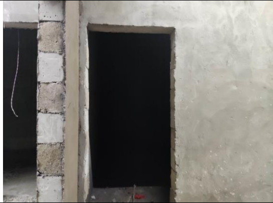
拟建后装机北侧操作间
